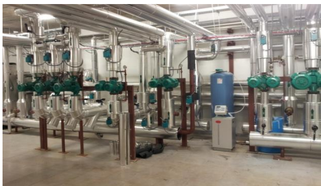
EDIFICIO IMDEA ENERGIA MOSTOLES (MADRID)
