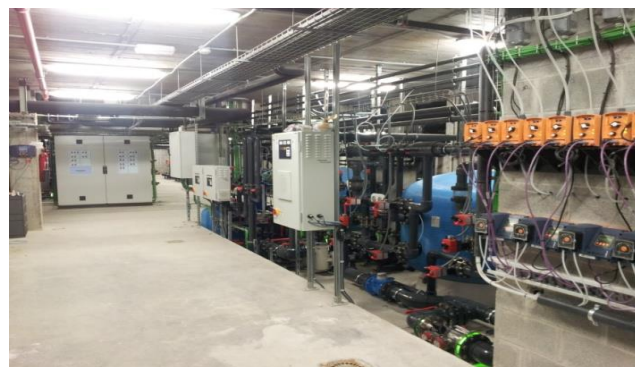
COMPLEJO DEPORTIVO "PANDO AISIA" PORTUGALETE (VIZCAYA)
