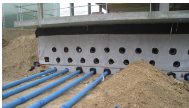
EDIFICIO LUCIA DE LA UNIVERSIDAD DE VALLADOLID INSTALACIÓN DE POZOS CANADIENSES
