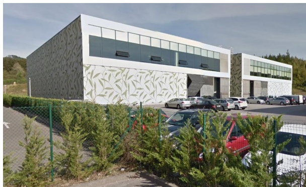
NAVES MICRODECO-PIERBURG (AUTOMOCIÓN) AMOREBIETA (VIZCAYA)
