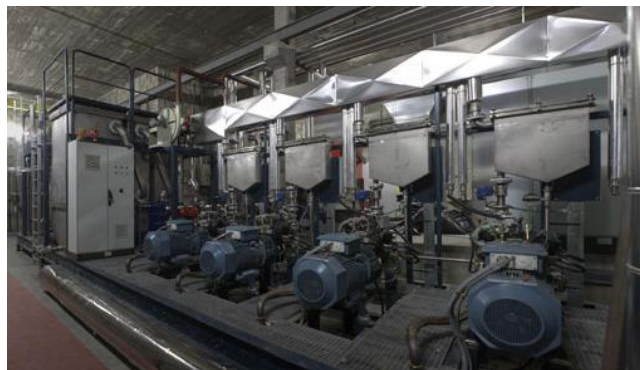
EDIFICIO LUCIA DE LA UNIVERSIDAD DE VALLADOLID INSTALACIÓN DE TRIGENERACIÓN 100 kW e 180 kW t ALIMENTADA POR ASTILLA DE MADERA
